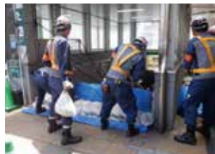
▲止水板及び土のうの設置訓練
