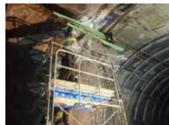
▲長寿命化工事
