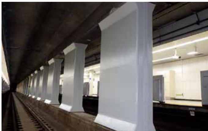
▲耐震補強工事を施した地下部の柱
