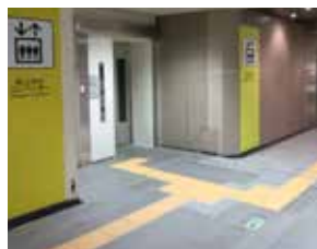
▲誘導ブロック
