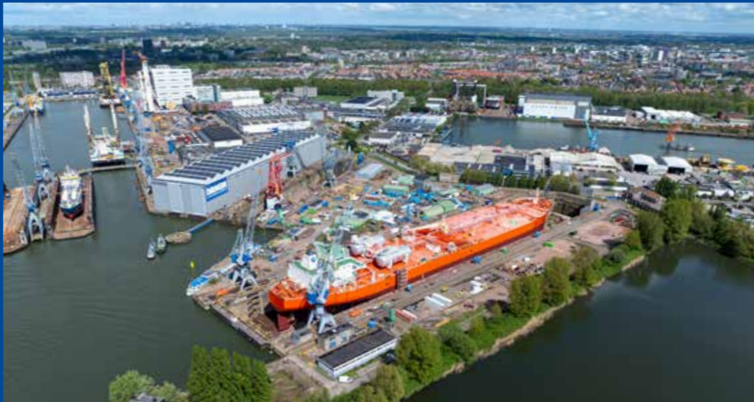
» Damen Shiprepair Rotterdam, Schiedam
